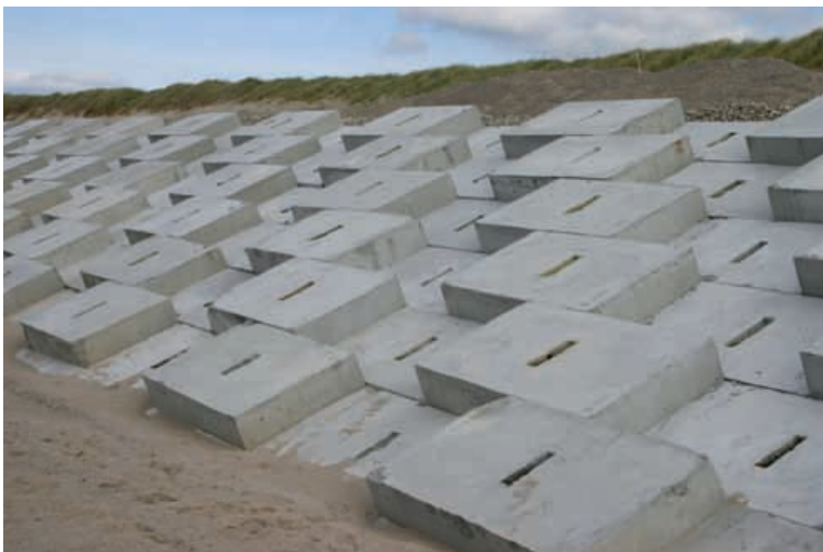
Fig. 5.1 Eksempel på en skråningsbeskyttelse
