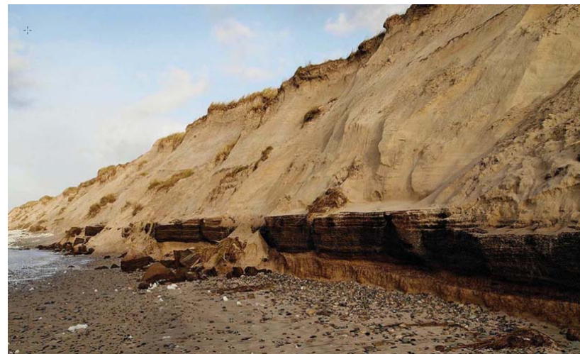
Ingen sikring af kliffoden
